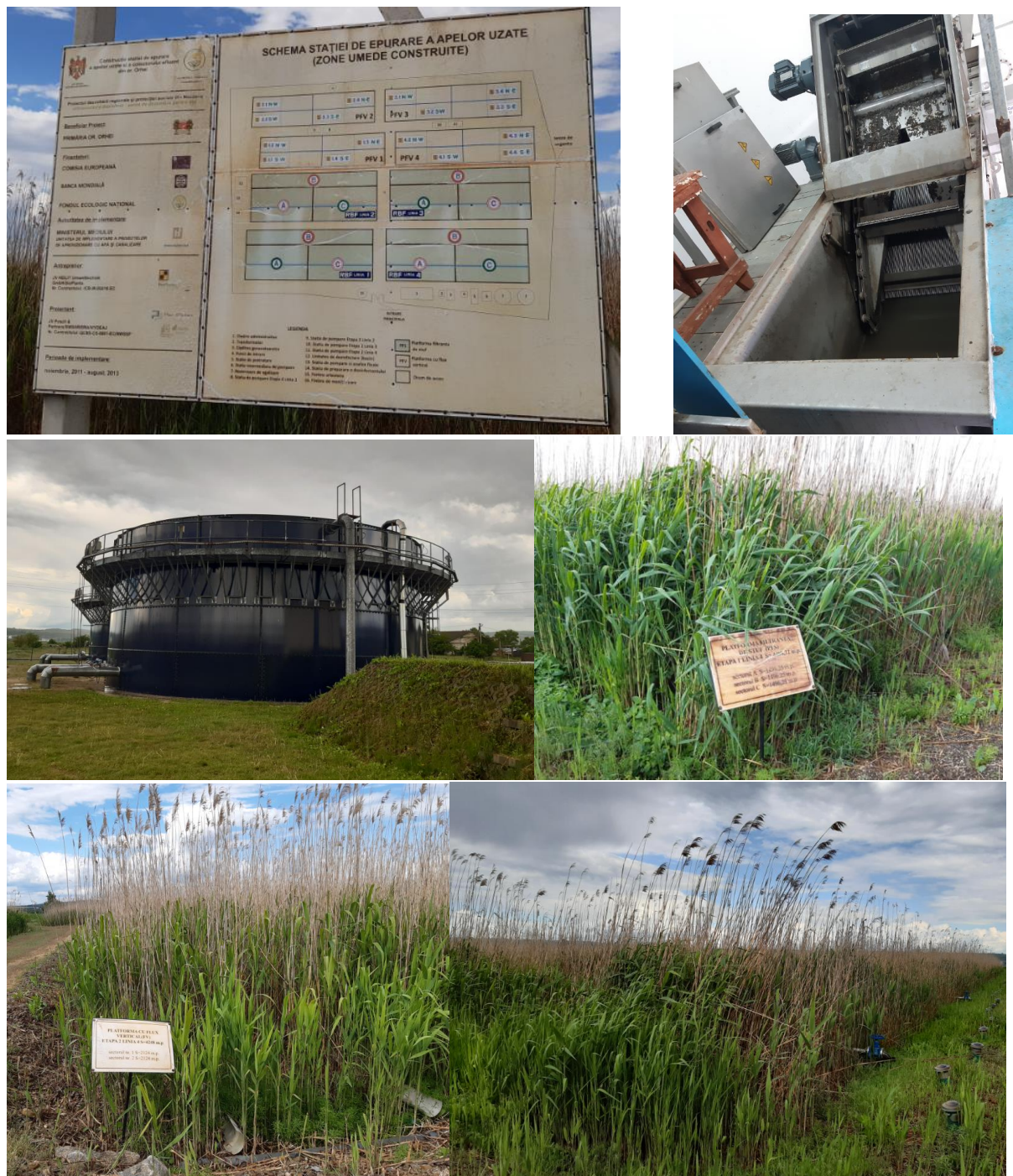
Figura 78: Noua stație de epurare din Orhei bazată pe Zonele Umede Construite
