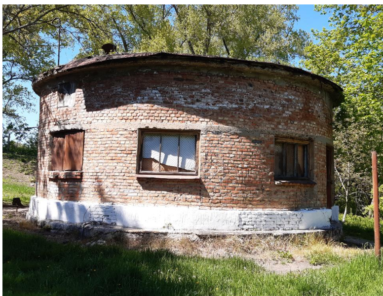
Figura 21 :Stația de pompare Nord
