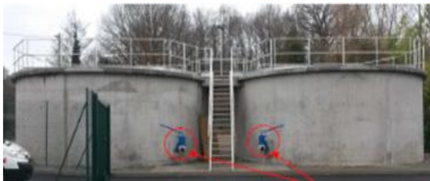
Figura 92 : Rezervoare Imhoff
