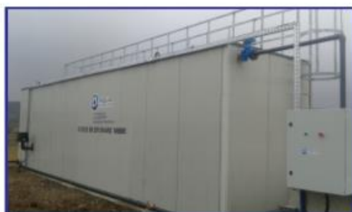
Figura 79: Stație de epurare de capacitate mică prefabricată și containerizată de la Aqua System Plus SA
