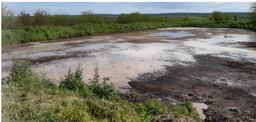
Figura 104: Pat de uscare în vechea stație de epurare din Orhei
