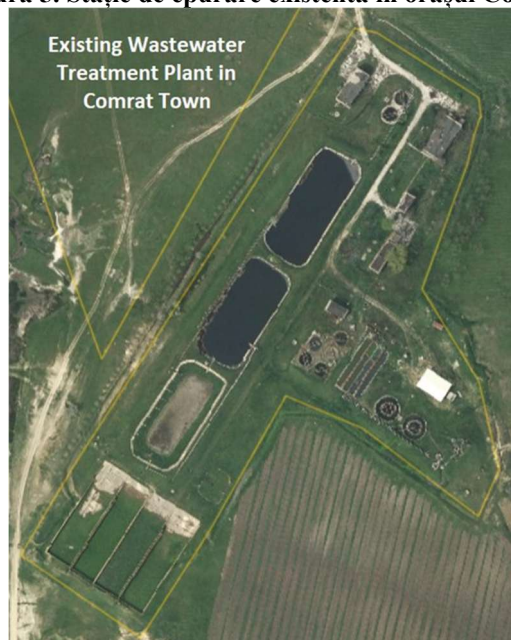
Figura 5. Stație de epurare existentă în orașul Comrat
