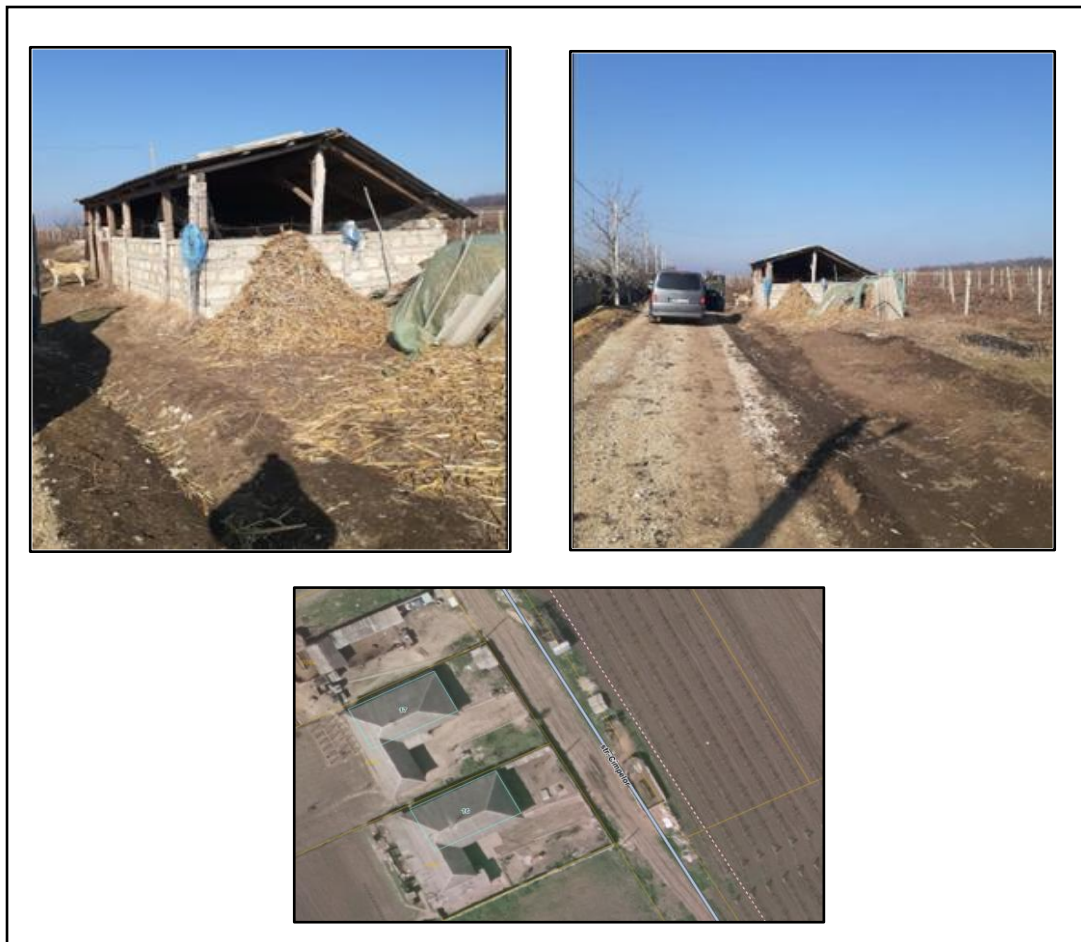
Figura 2. Depozit situat pe strada Câmpilor, în satul Pelinei (17362040163), supus unei posibile demolări, întrucât împiedică accesul viitor la conductele rețelei de distribuție
